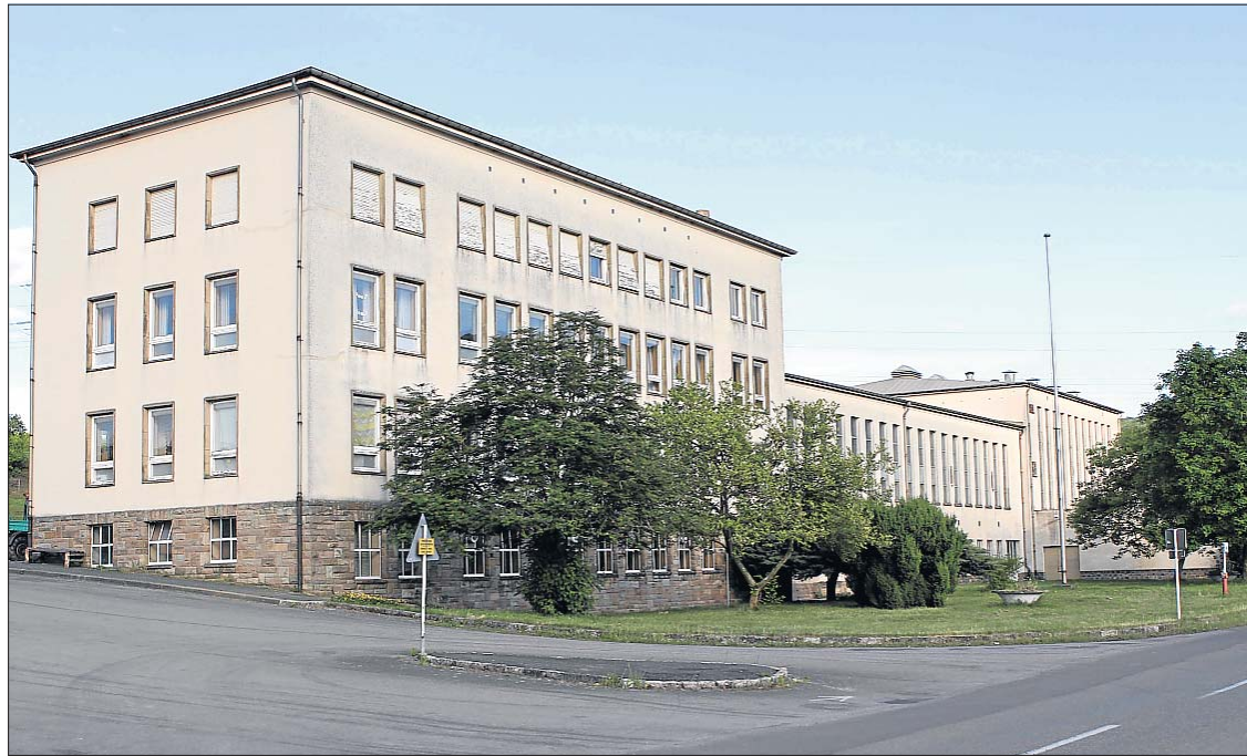
Das Gelände der ehemaligen Laduno bei Erpeldingen soll durch die Abänderung des PAG einer neuen multifunktionalen Bestimmung zugeführt werden, indem hier voraussichtlich ein Fitness-Wellnesszentrum sowie ein Businesshotel entstehen.
