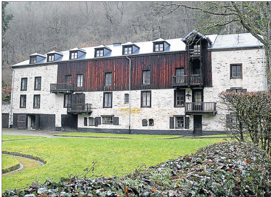
Die Eschweiler Mühle soll laut Denkmalschutzamt als nationales Denkmal klassiert werden. (FOTO: JOHN LAMBERTY)
